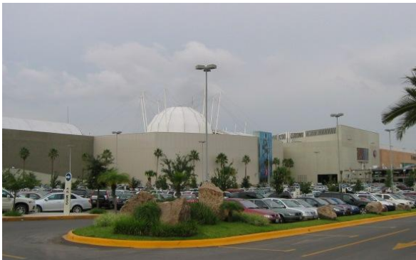
ARRIBA: PLAZA GALERIAS. Esta plaza originalmente se construyó para albergar la PLAZA HEMISFERIA, proyecto cancelado por “El Error de Diciembre”.
